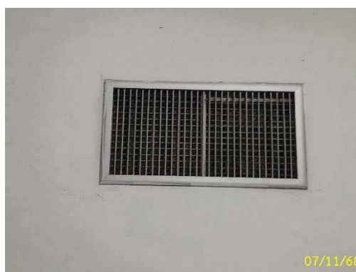
การระบายอากาศวิธีกลของบันไดหนีไฟ และลิฟต์ดับเพลิง
